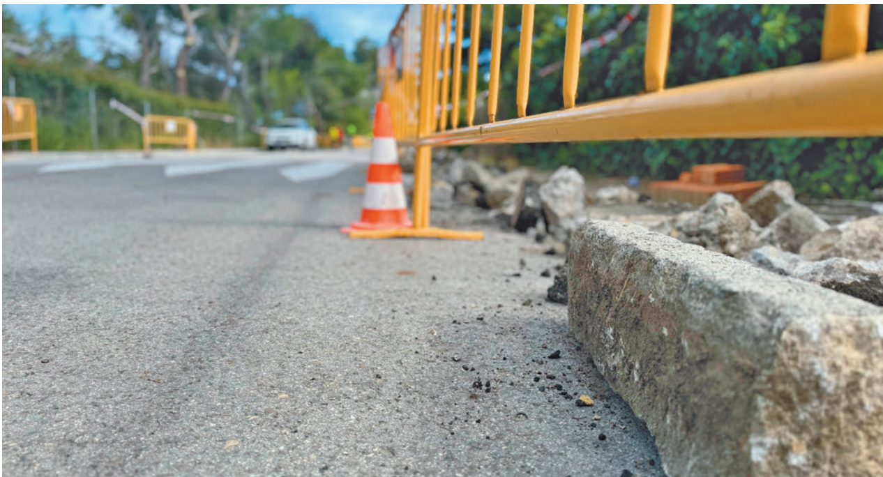
Los trabajos, en una de las aceras de la urbanización roceña
