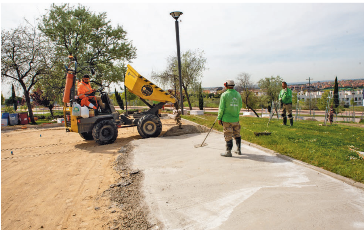
Inicio de los trabajos en el área infantil del parque de El Encinar
