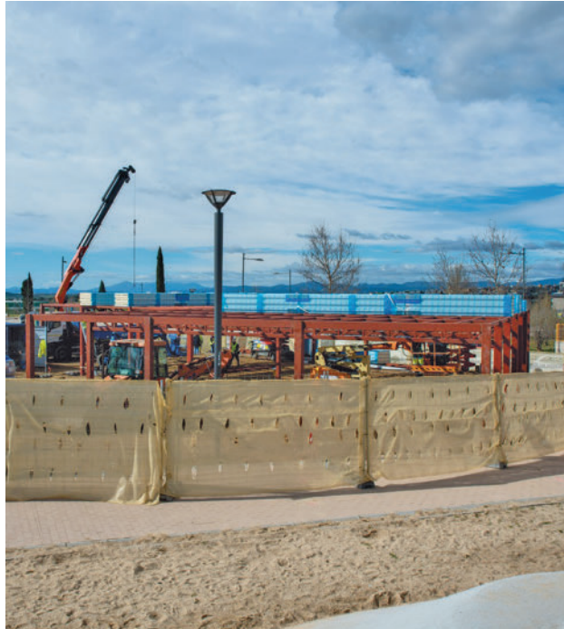
Los trabajos de construcción de la nueva infraestructura
