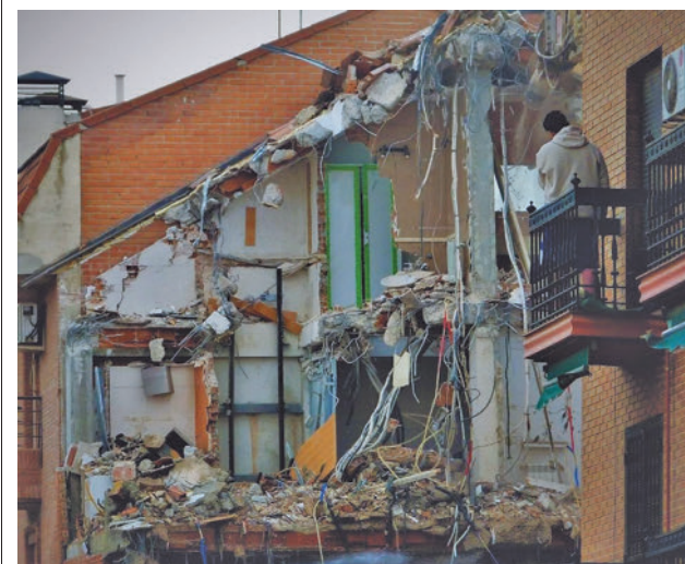
Obras de derribo de un inmueble
