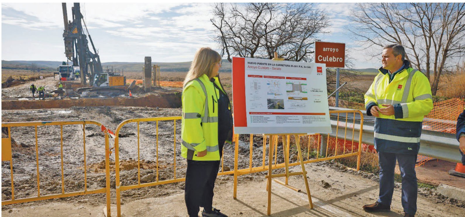
El consejero de Vivienda, Transportes e Infraestructuras, Jorge Rodrigo, durante la visita a la zona COMUNIDAD DE MADRID
