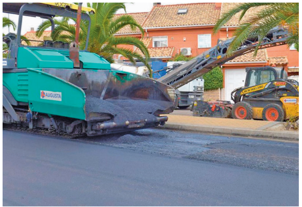
Trabajos de asfaltado en Valdemoro
