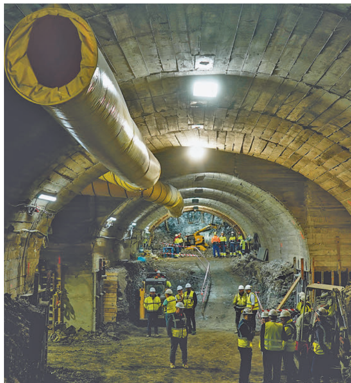
Obras de ampliación de la L3 de Metro
