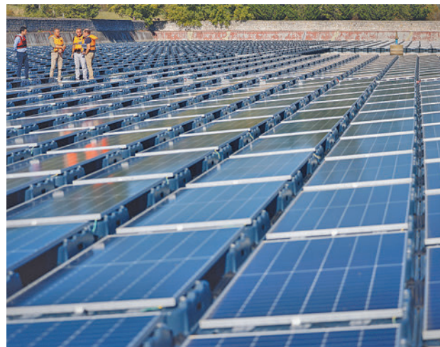
Instalación fotovoltaica de Torrelaguna
