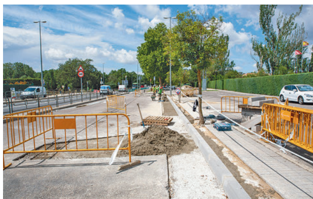
Estado de las obras
