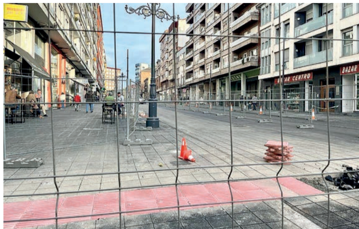
Obras en la calle Julián Ceballos.
