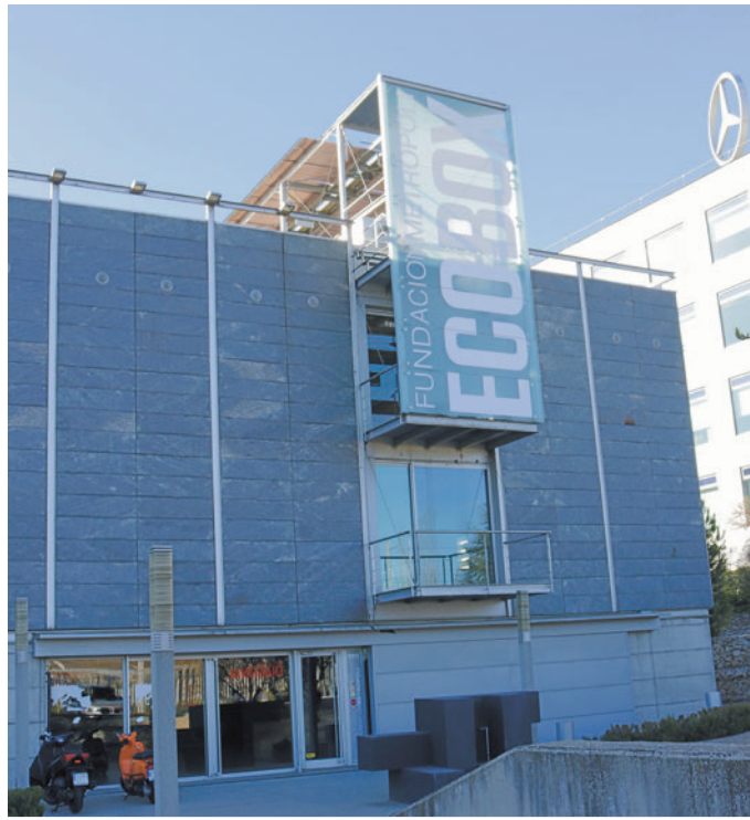
ECOBBOX: La sede de Fundación Metropoli (Avenida de Bruselas, 28, Alcobendas) aúna la vanguardia arquitectónica en cuanto a diseño con la eficiencia energética, a través del uso de energías renovables que aseguran una excelente climatización.
