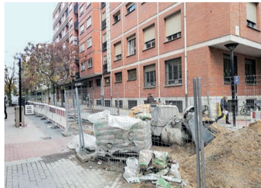
Zona comercial de las Cien Tiendas, en obras.
