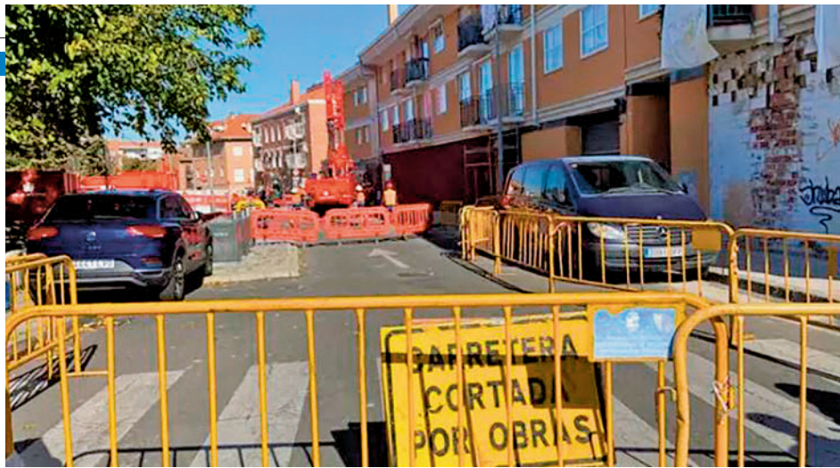
Obras en la 'zona cero' de San Fernando de Henares E.P.
