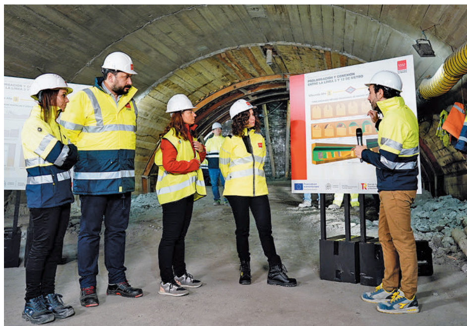
Visita de Isabel Díaz Ayuso a las obras de la Línea 3
