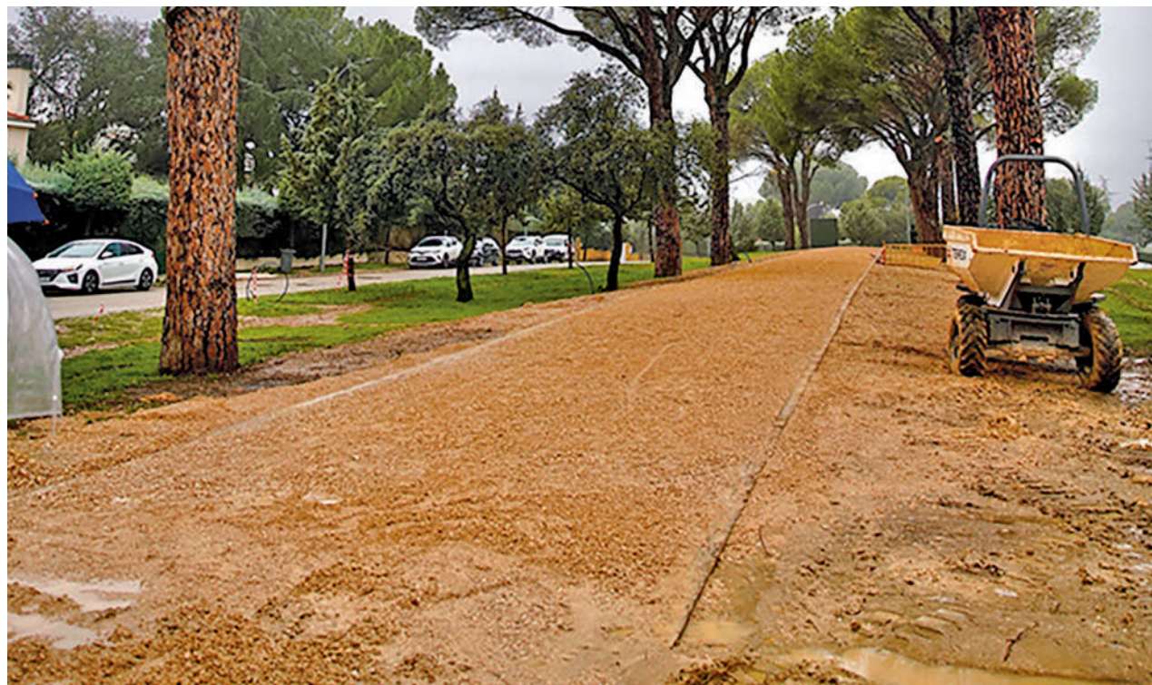
La zona de Doce Apóstoles, durante las obras
