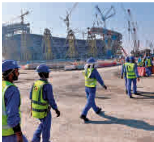
Trabajadores en los estadios
