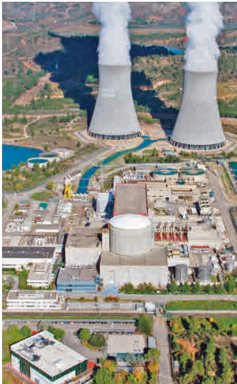
Panorámica de la central nuclear de Cofrentes
