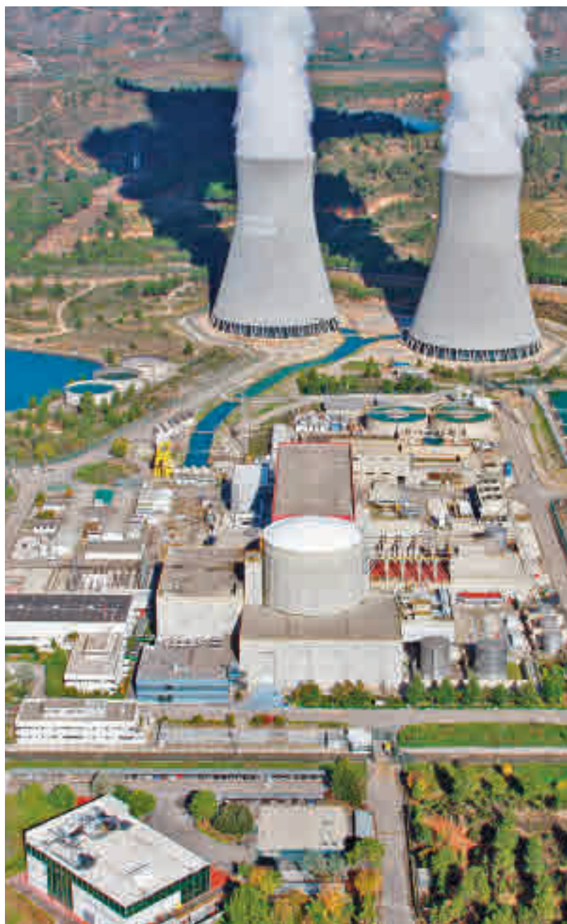
Panorámica de la central nuclear de Cofrentes
