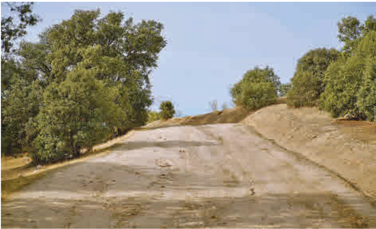
Uno de los caminos en los que se está actuando
