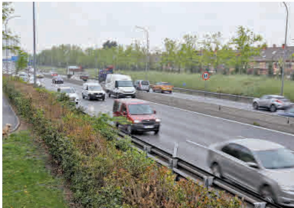
Barrera acústica en la autovía de Toledo
