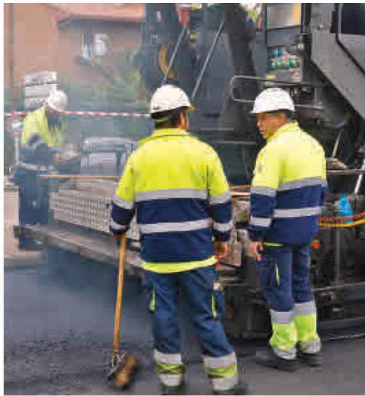
Cinco operarios esparcen el asfalto en la avenida de Logroño
