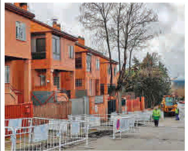
Varios obreros trabajan en la zona objeto de remodelación
