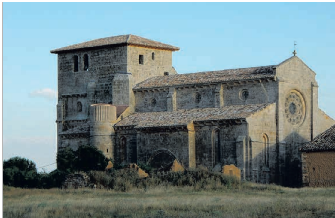
Vista exterior de la iglesia de Santiago Apóstol de Villamorón, de finales del siglo XIII. Se cerró al culto en los años 70 del pasado siglo.
