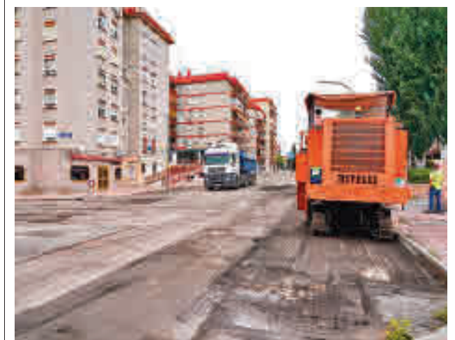
Máquinas actuando sobre el firme de Móstoles
