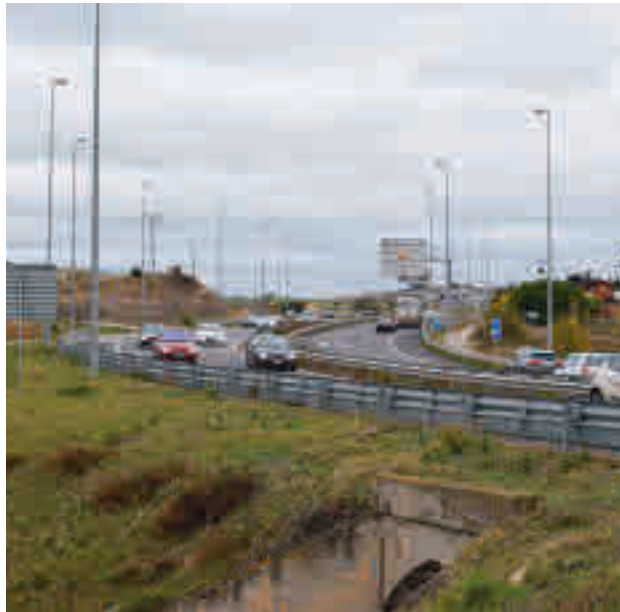
Tramo de la carretera M-607 entre Colmenar y Tres Cantos
