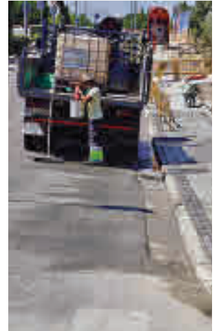
Los trabajos, en marcha
