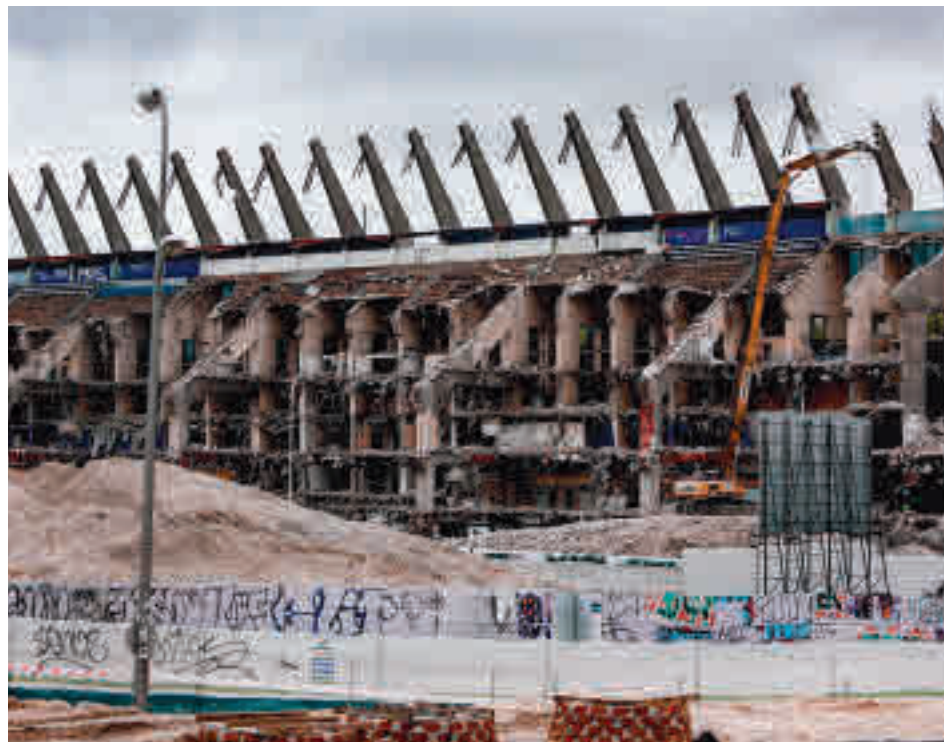
Obras de derribo del estadio Vicente Calderón
