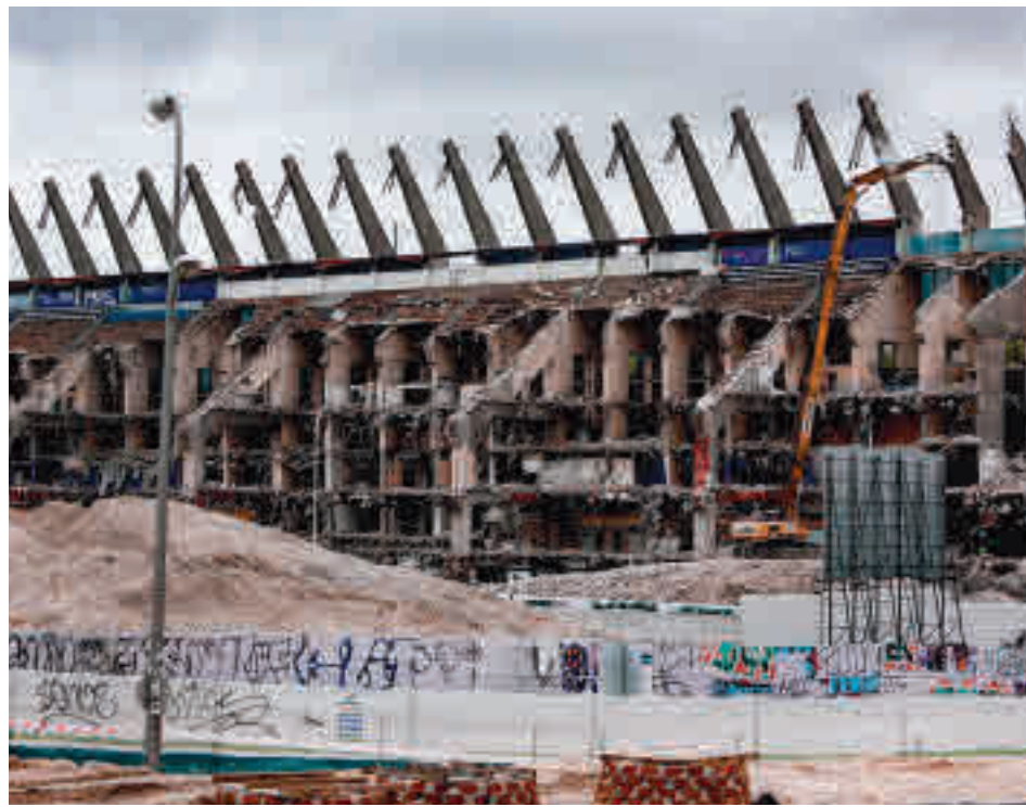
Obras de derribo del estadio Vicente Calderón
