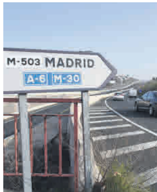
Una nueva pasarela sobre la M-503
