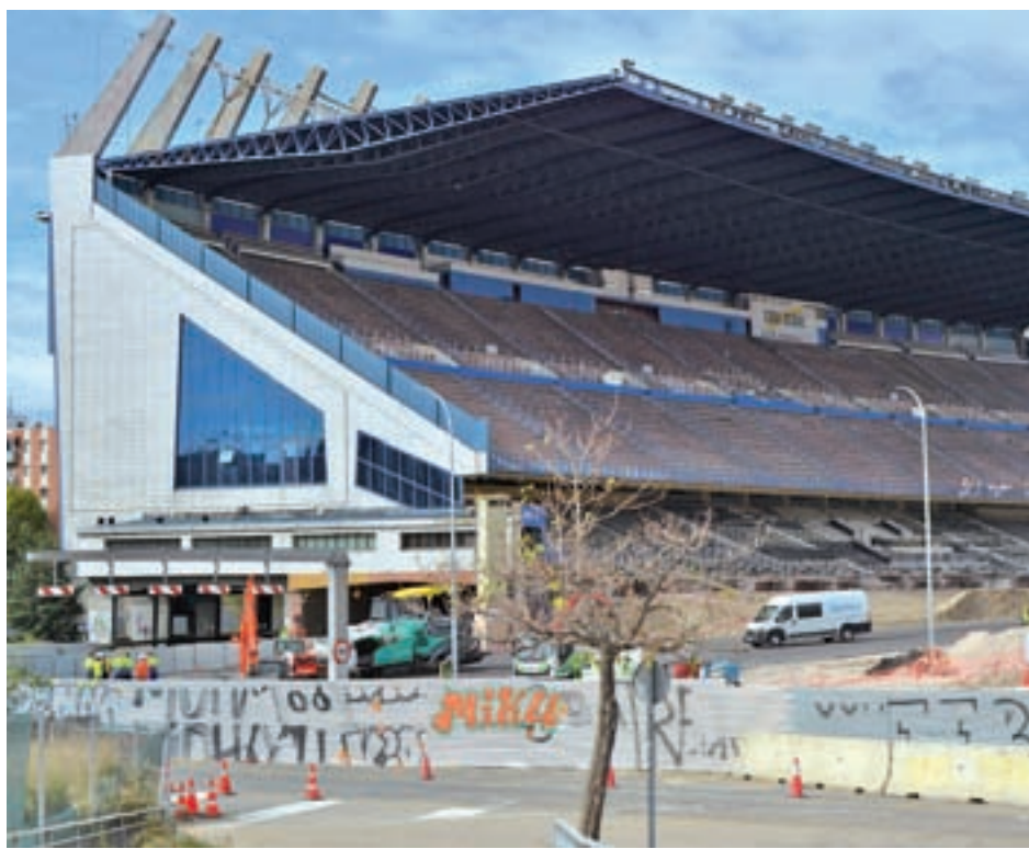
Obras en el Vicente Calderón PEPE RIOFRÍO / GENTE
