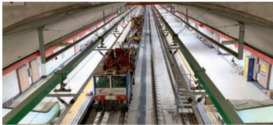
Obras en el túnel de Recoletos
