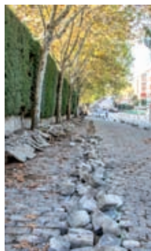
Obras en las aceras
