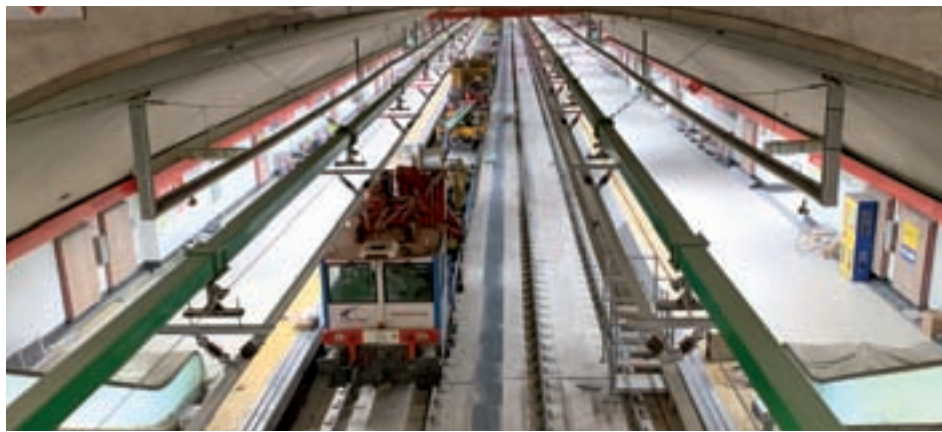
Obras en el túnel de Recoletos
