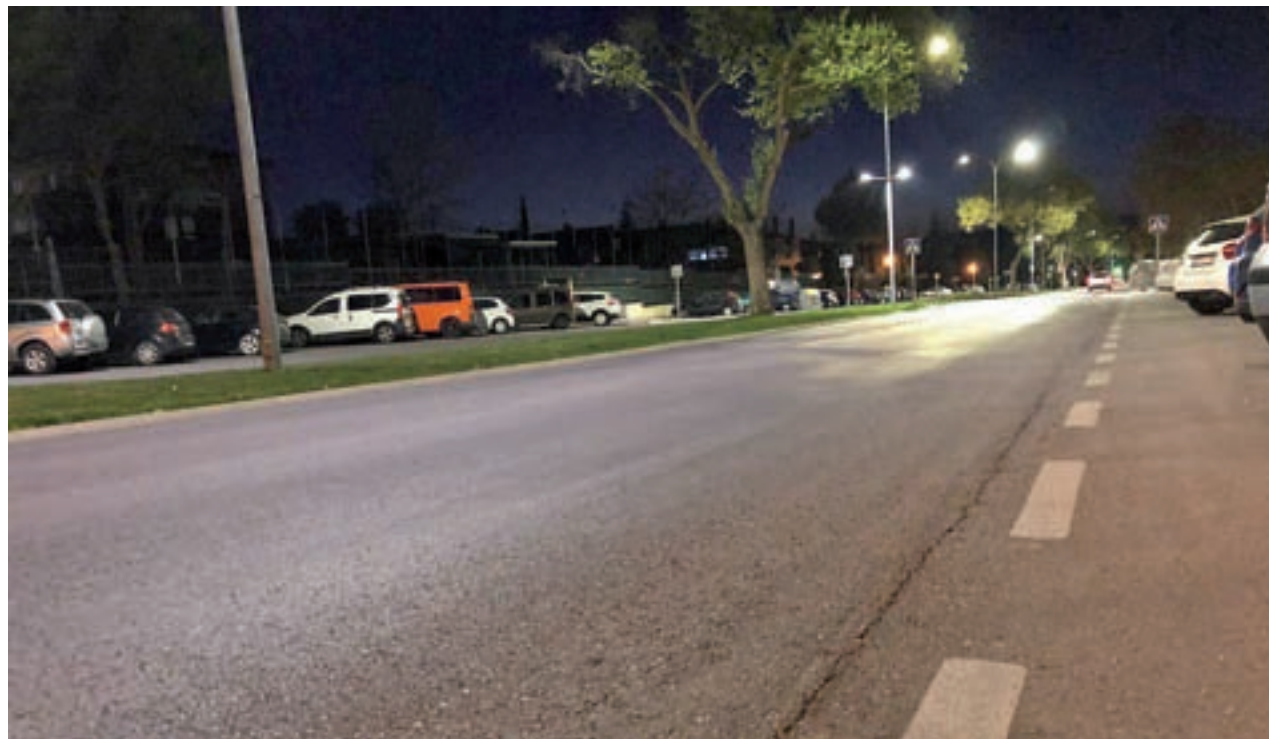
Las nuevas luminarias
