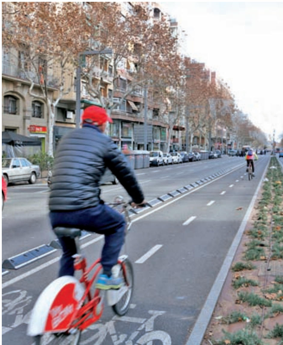
Actualment hi ha tres carrils bici en obres de construcció. ACN
