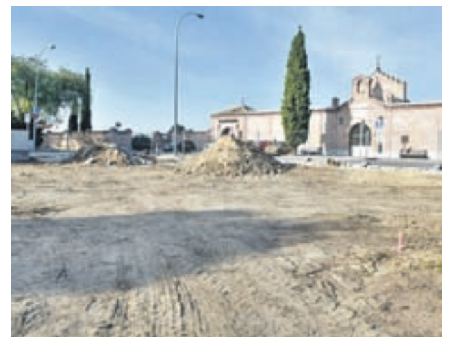
El inicio de los trabajos
