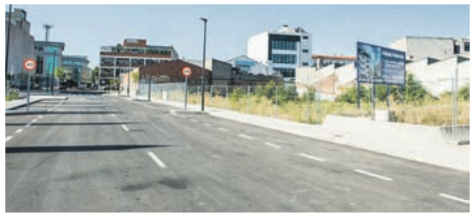
Zona de la Estación
