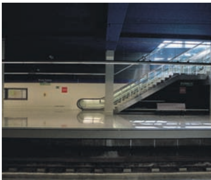
Uno de los andenes Rivas Futura, en la línea 9
