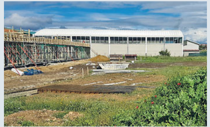
Estado actual de las obras de ampliación del colegio 'Los Adiles'.
