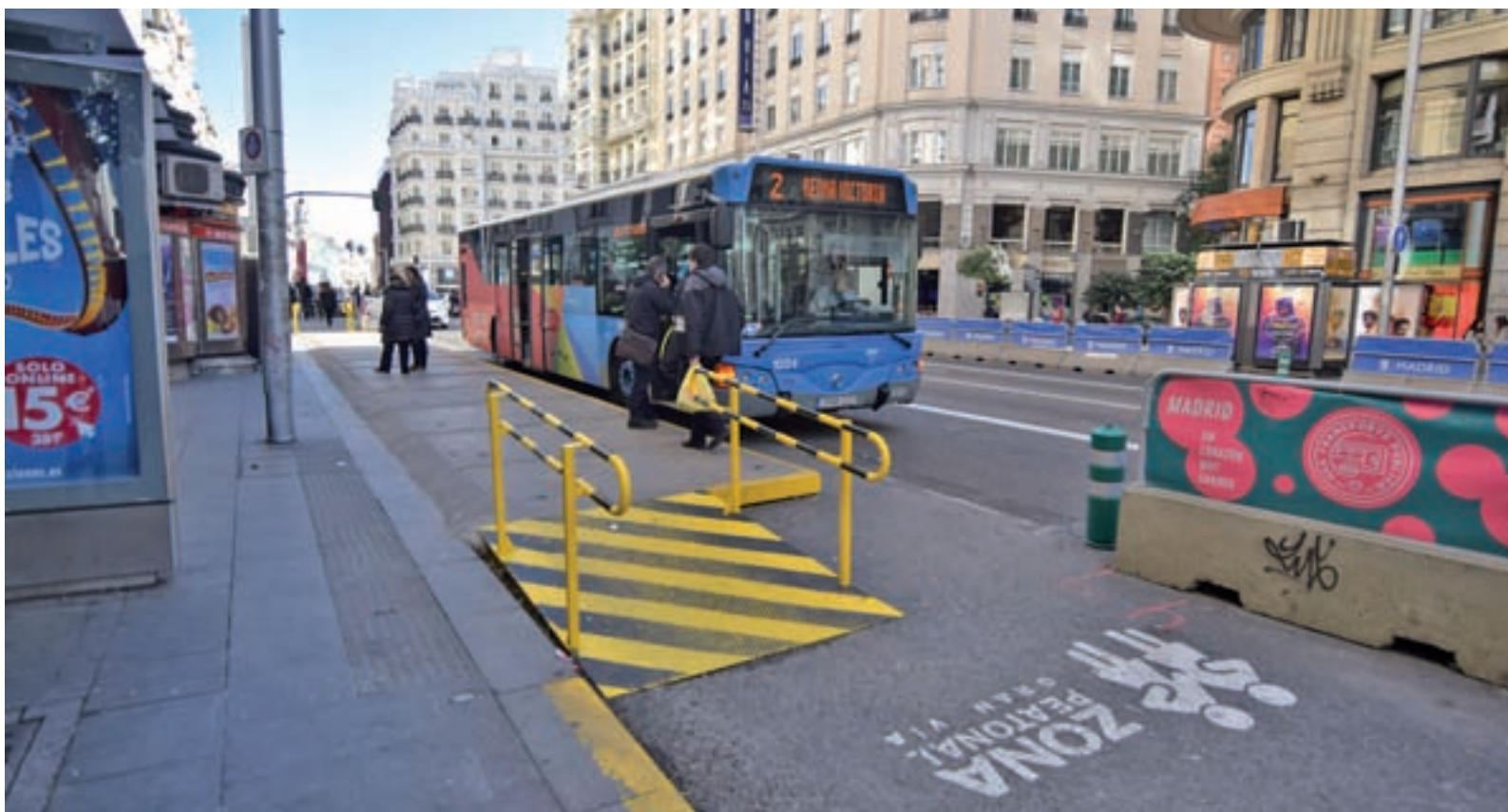
Los trabajos en la emblemática calle madrileña durarán 13 meses
