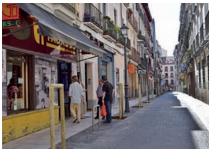
Chueca ya está en marcha: La pavimentación de las calles de Hernán Cortés, Farmacia, Infantas, Reina y el primer tramo de Barbieri y Libertad ya está terminada. También se trabajará sobre Santa Brígida, Augusto Figueroa, San Marcos, Costanilla de los Capuchinos y San Bartolomé.
