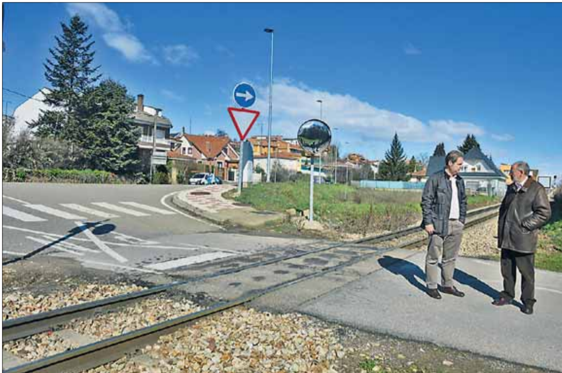
El paso a nivel de 'El Ejido' es un punto peligroso al no estar dotado de barreras ni de otras medidas de seguridad.
