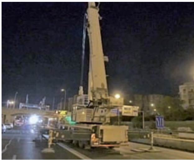
Obras en el puente de la avenida del Mediterráneo
