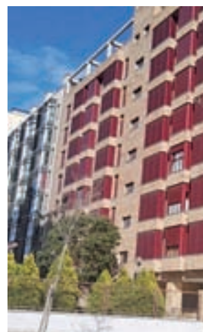
Viviendas en Madrid
