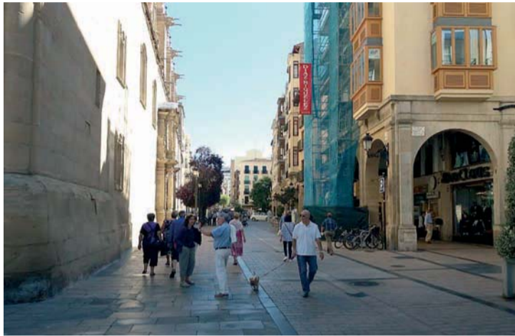
Gran parte de las obras se realizará en inmuebles del casco antiguo de la ciudad.
