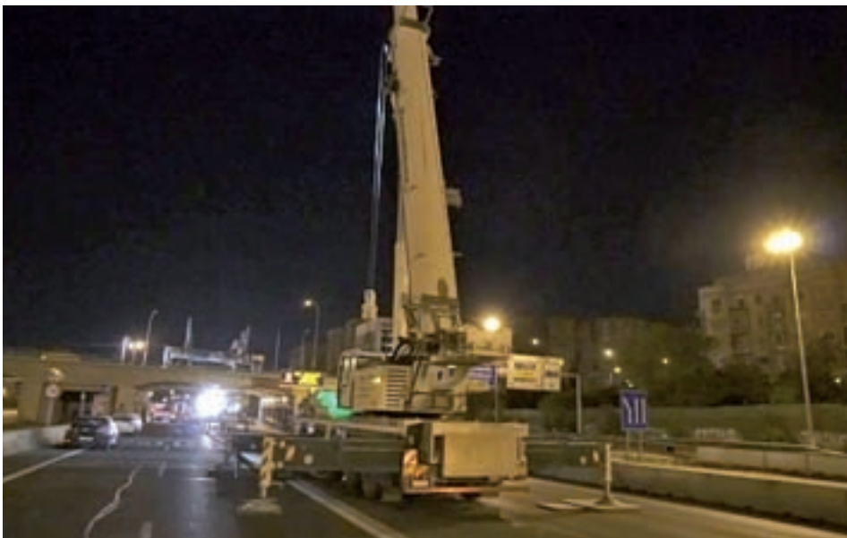
Trabajos en la avenida del Mediterráneo
