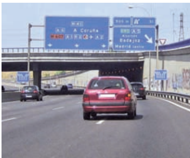
Tramo sobre el que se actuará
