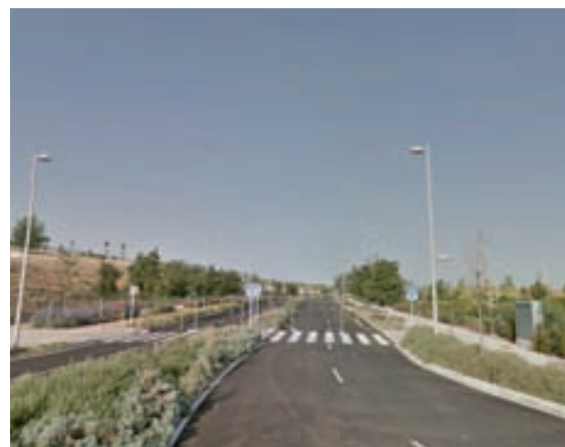
La Avenida de Francisco Javier Sáenz de Oiza
