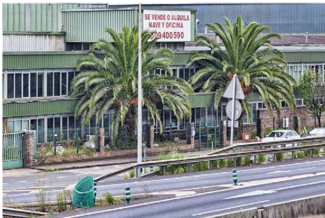
Imagen actual de las naves donde estuvo la empresa Nestor Martin en Maliaño.
