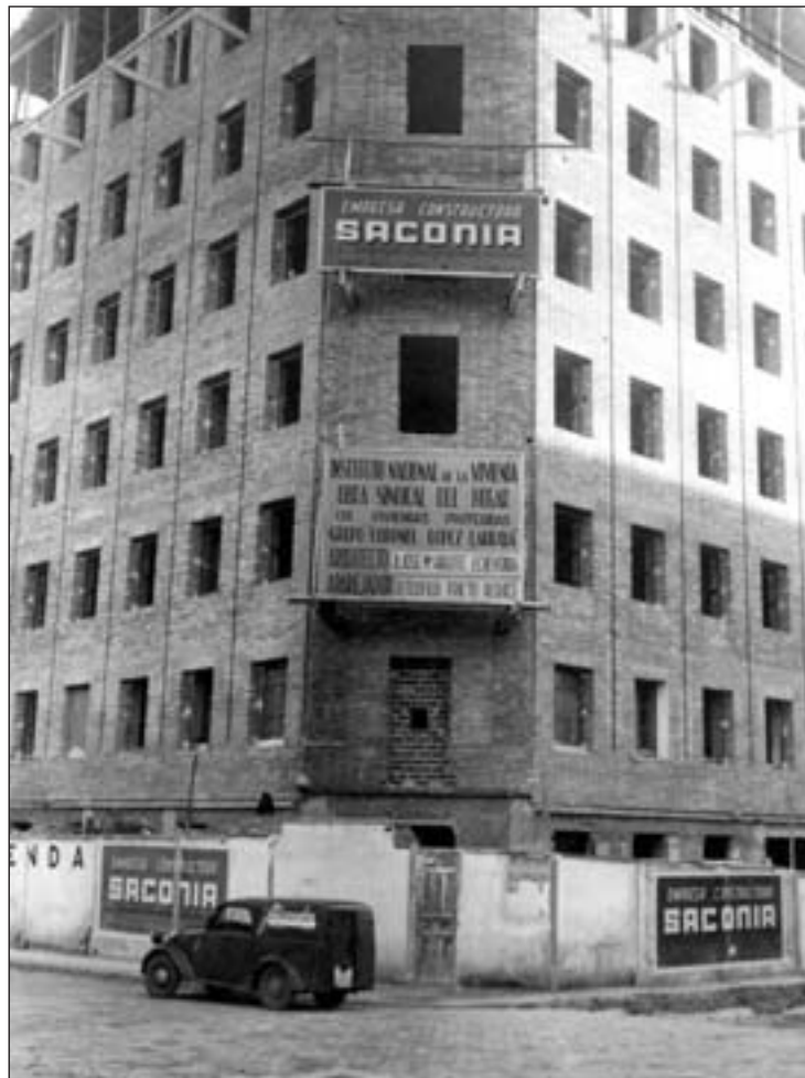
El edificio, durante su construcción ASOCIACIÓN DE VECINOS
