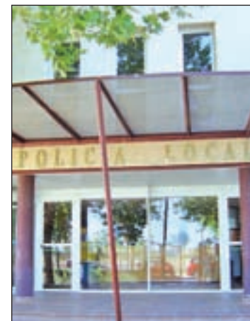
Edificio de la Hispanidad
