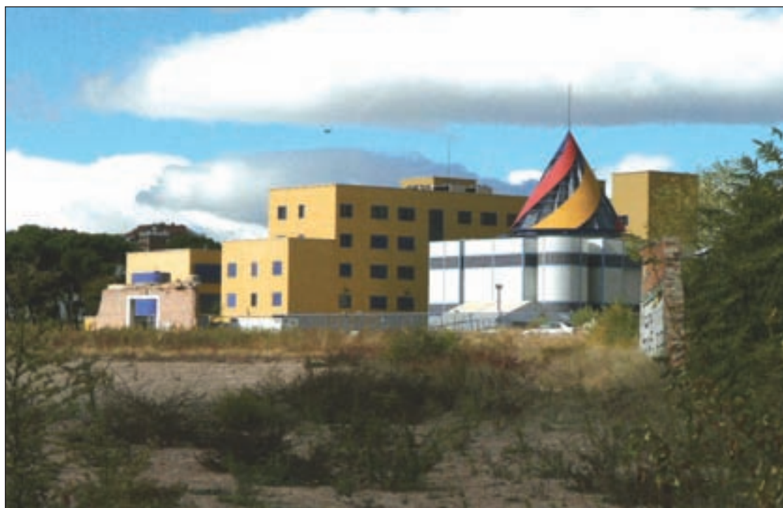
El Centro de Internamiento ocupa las dependencias del antiguo hospital penitenciario
