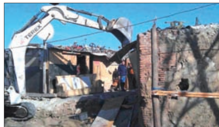
Uno de los derribos realizados en el núcleo marginal
