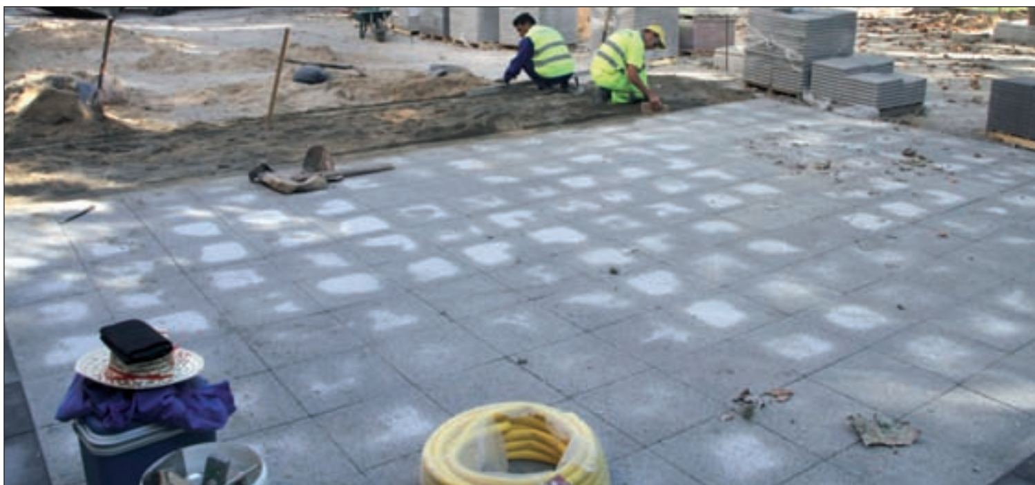
Obras de pavimentación en la plaza Calderón de la Barca
