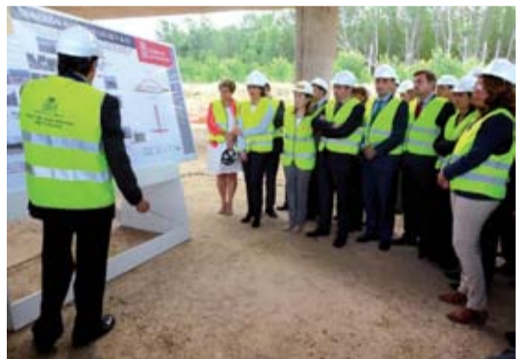
Visita a la colocación del tablero en el puente sobre el Ebro.
