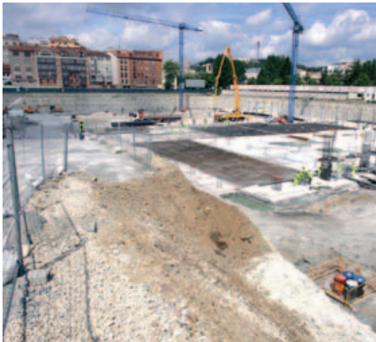
Hace un año que comenzaron las obras del solar de Caballería.
